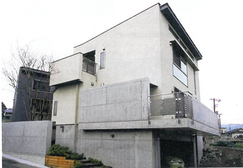
南側外観。外壁には室内と同じ左官材を、仕上げの表情を変えて用いた（写真：中澤建築設計事務所）
